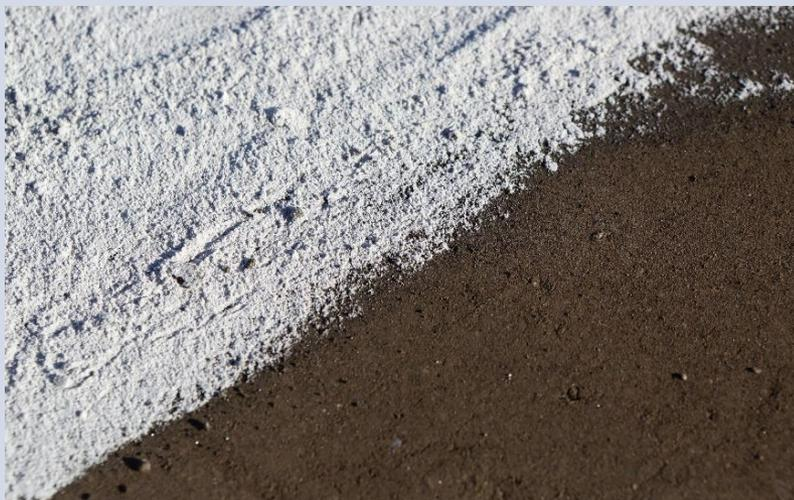
6. Перемешивание «Шлакогрунта» с внесенными в строгой пропорции модификатором и цементом с постоянным контролируемым дозированием воды.
