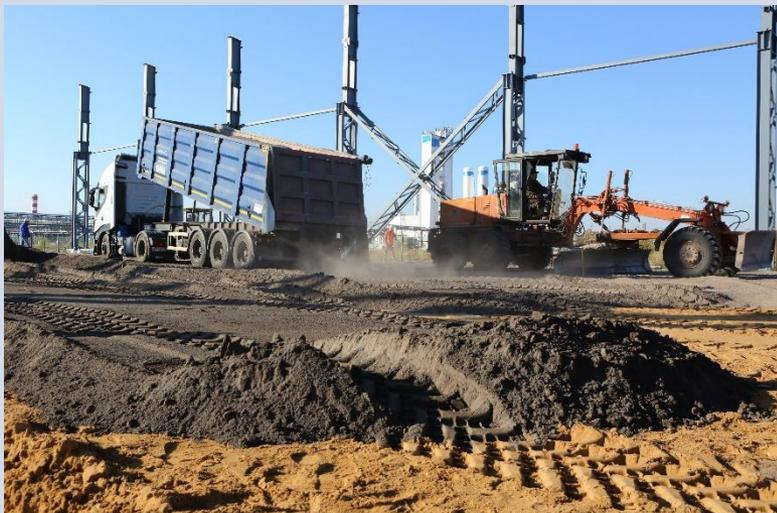
1. Завоз и распределение отсева фракции 0\*5 сталеплавильного щебня конвертерного производства
