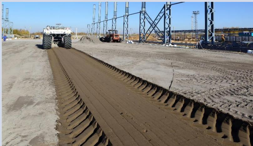
3. Перемешивание существующего грунта с отсевом фракции 0\*5. Создание рабочего полотна «Шлакогрунт».
